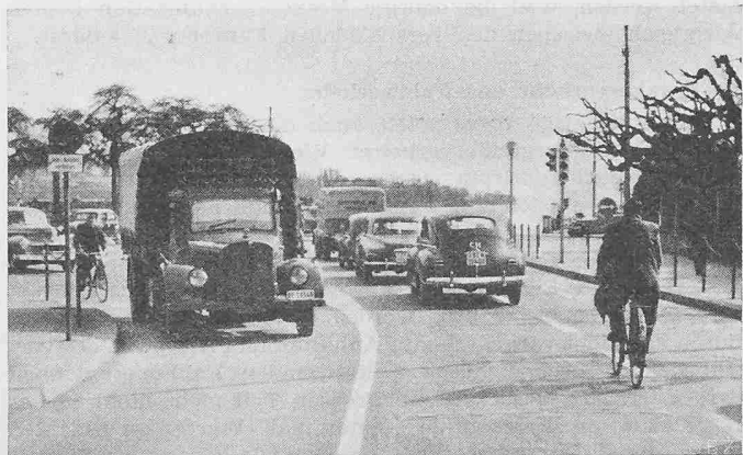
Bild 7. Blick von der Talstrasse auf den Bürkliplatz. Links die gefährliche Einfahrt mit ihrer plötzlichen Fahrbahnverschmälerung
