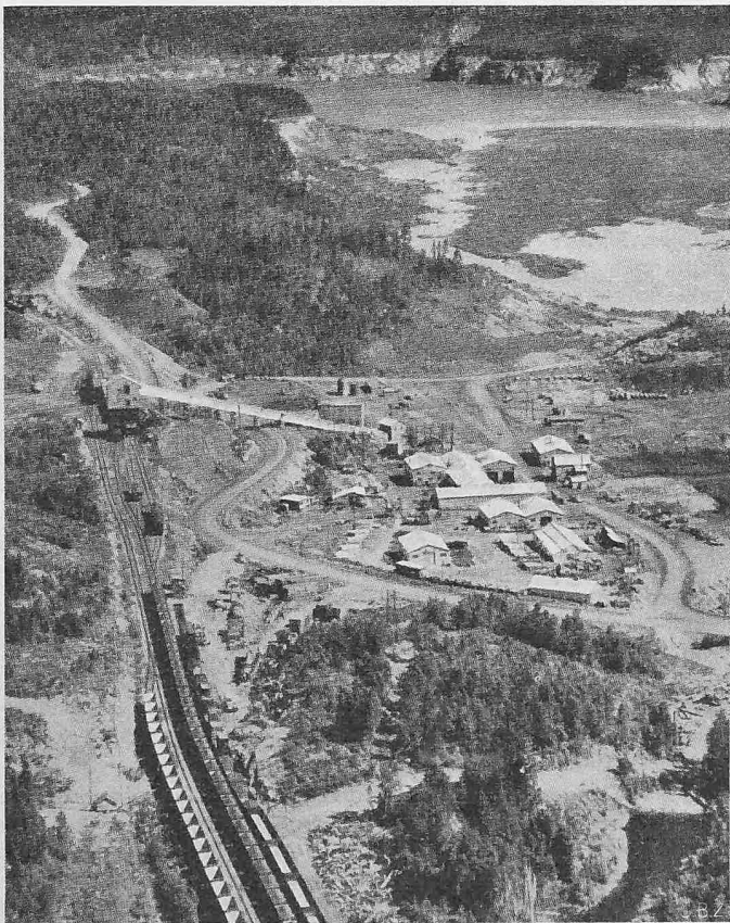
Bild 1. Erzverladestation am Steep Rock-See. Die unbewaldeten Uferpartien geben die Höhe der Seeabsenkung an. Links die Erzbahn, beschickt durch das schiefe Transportband in der Mitte
