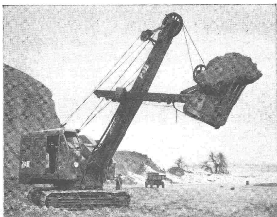
Löffelbagger mit Tru-Lay-Brugg-Drahtseilen ausgerüstet
