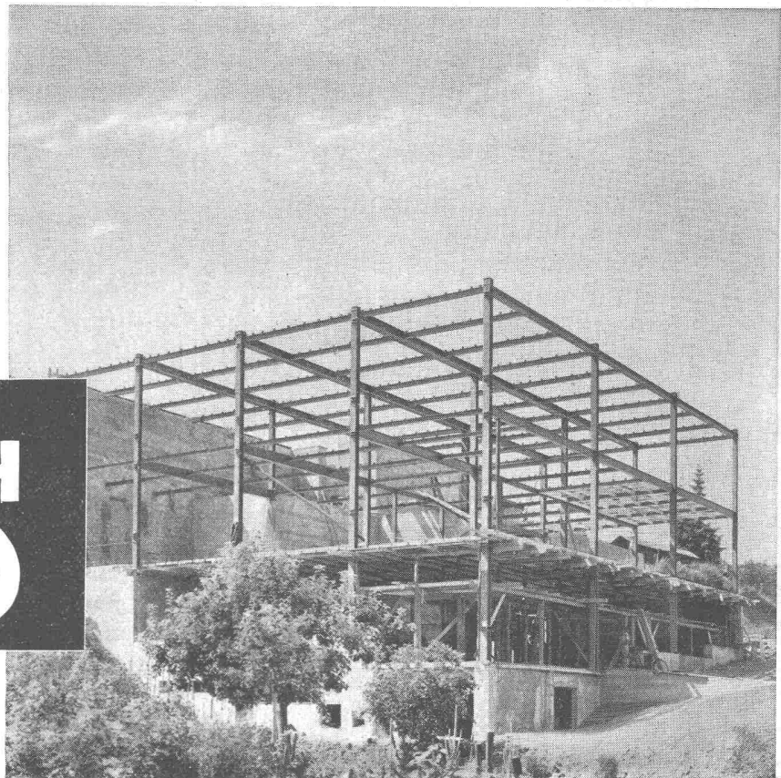
Stahlskelett für Fabrikneubau
