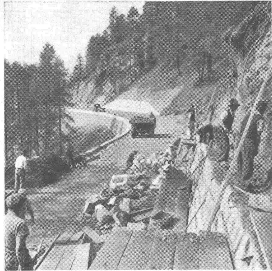
Verlegung der Julierstrasse in Marmorera
