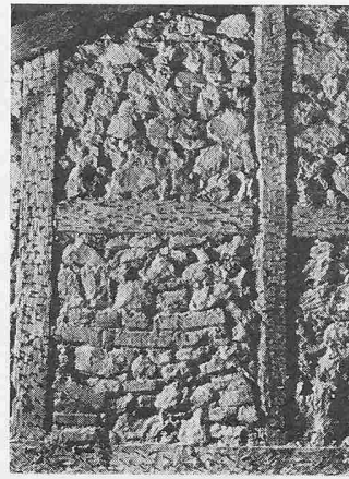
Eichenholznägel als Putzträger im alten Riegelmauerwerk
