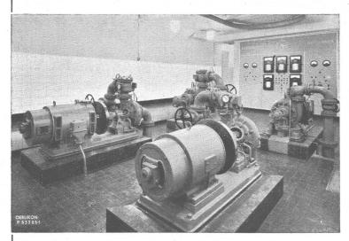
Trinkwasser-Pumpstation Calvaire bei Lausanne, ausgerüstet mit total drei Oerlikon-Combimotoren für 35, 55 und 75 PS.
