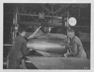
Bild 4. Abschneiden einer Eternit-Platte von der Formatwalze
