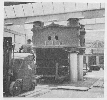
Bild 7. Hydraulische Presse von 7500 t
