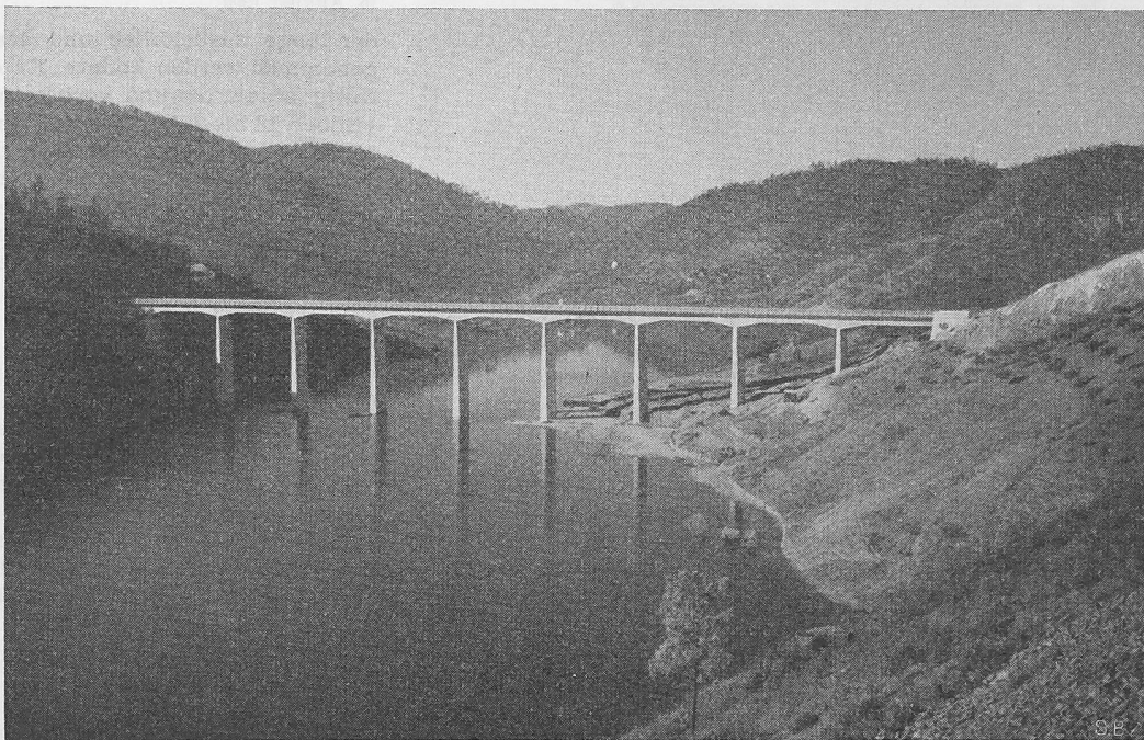
Bild 23. Strassenbrücke «Vale da Ursa», 35 km oberhalb der Staumauer. 300 m lang, Fahrbahn 50 m über Talweg, Eisenbeton-Gerber-Träger mit 30-m-Oeffnungen, Pfeiler unarmiert
