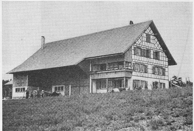
Bild 2. Dreisässenhaus bei Ossingen, Kt. Zürich. Der Riegelbau kann dank verbesserter Konstruktion vermehrt angewendet werden
