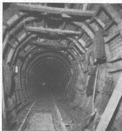
1140 m Stollen mit 30 lfm Schalung
