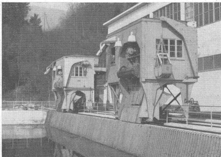
Kraftwerk Rapperswil-Auenstein — Zwei halbautomatische Rechenreinigungsmaschinen, wovon eine mit schwenkbarem Greiferbagger für die Reinigung der Dammbalkennuten
