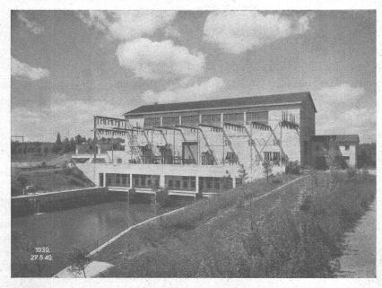
Kraftwerk Rupperswil-Auenstein — Maschinenhaus / Trafostation Befahrbarer Gussasphaltbelag ca, 1000 m<sup>2</sup>
