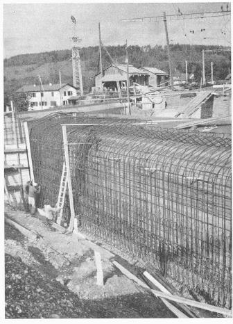
Bild 16. Schalung und Armierung der Wände
