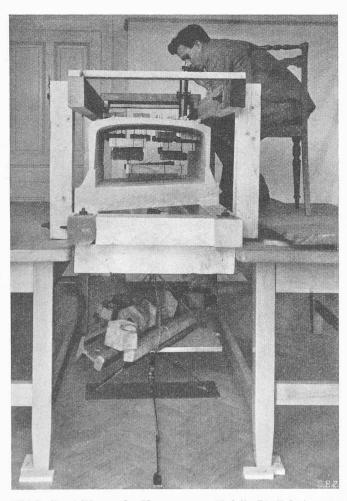
Bild 5. Durchführung der Messungen am Modell: Die Belastung  $\Sigma P=200\,\mathrm{kg}$  wird mit Hebel-Uebersetzung und hölzernen Schwellen auf die Platte des Modells gleichförmig verteilt; optische Verdrehungsmessungen
