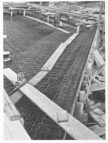
Bild 17. Armierung der Platte
