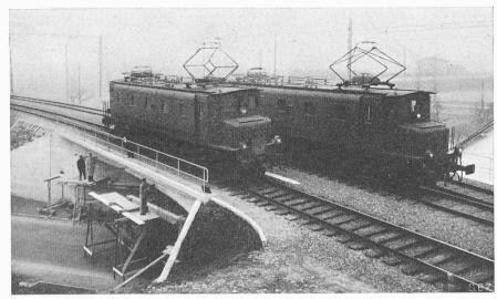
Bild 21. Belastungsprobe: 2 Lokomotiven Ae 4/7 auf Betriebs- und Abstellgleis
