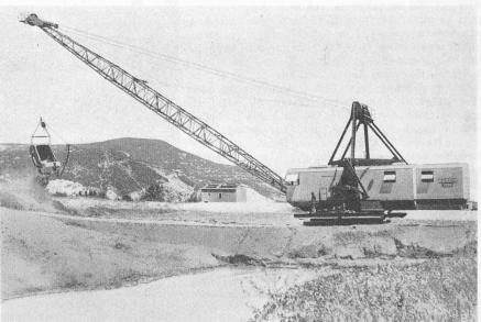
Bild 2. Eimerseilbagger «Marion 7200» am Oberwasserkanal
