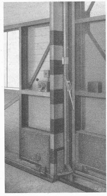
Bild 6. Torverschluss und Bodendichtung
