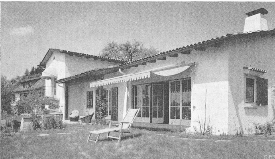
Bild 3. Die Gartenterrasse in inniger Verbindung mit Ess- und Wohnraum
