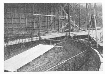
Bild 7. Bau des Wasserreservoirs mit innerer Scheidewand
