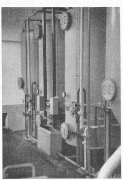
Bild 9. Vorenthärtungsanlage
