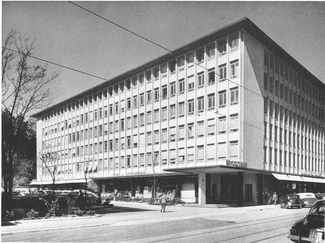
Bild 4. Ansicht der Hauptfassade vom Talacker aus, rechts die Eingangspartie, links der private Parkplatz
