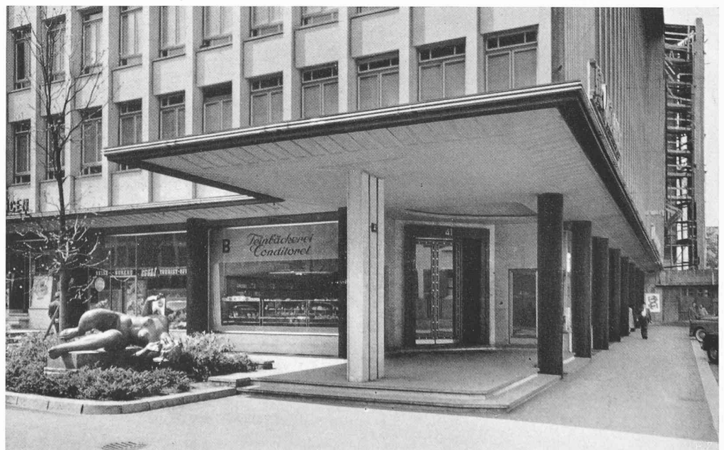
Bild 3. Vordach beim Eingang mit der Plastik «La Rivière» von Maillol
