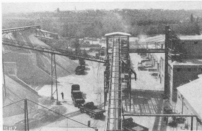
Bild 5. Splitt-Förderung mit Bändern: nach links auf die Halde, nach rechts in das Betonsteinwerk
