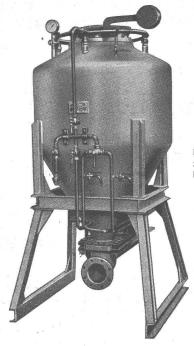
Betonier-Pneumatic zur pneumatischen
