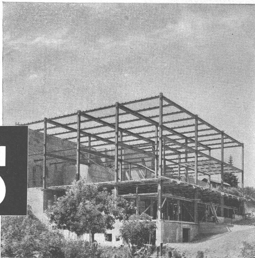
Stahlskelett für Fabrikneubau
