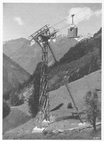
Bild 3. Stütze der Einseilbahn Bristen-Golzern, Kanton Uri
