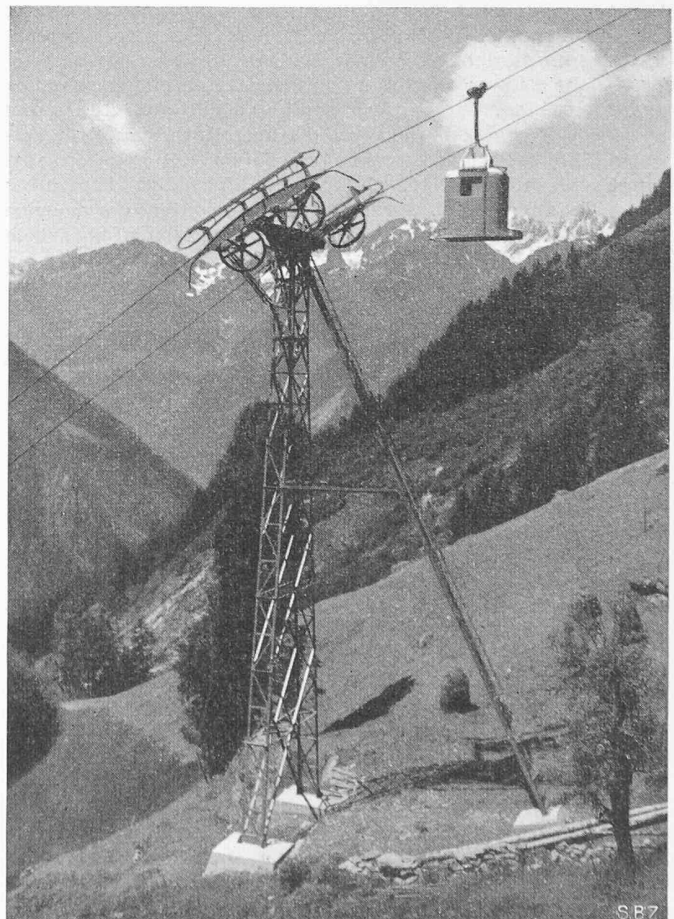
Bild 3. Stütze der Einseilbahn Bristen-Golzern, Kanton Uri
