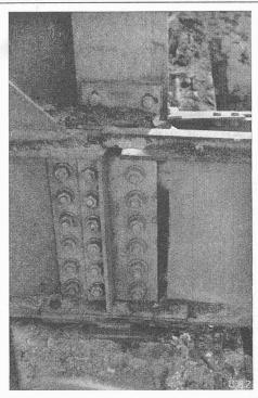
Bild 9. Dilatationsstoss einer Kranbahn. Der
