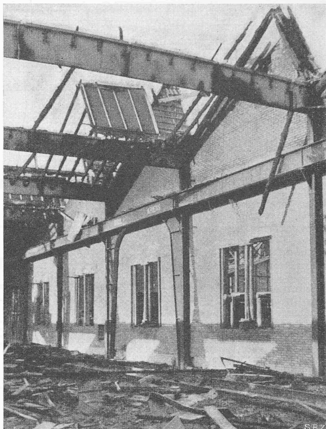
Bild 7. Partie mit schwach beschädigter Stahlkonstruktion
