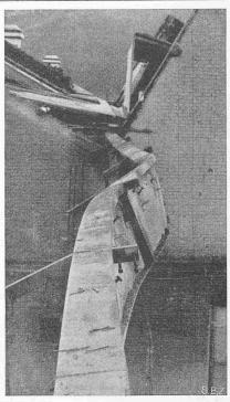
Bild 10. Stark beschädigter, nicht wieder verwendbarer Trägerteil
