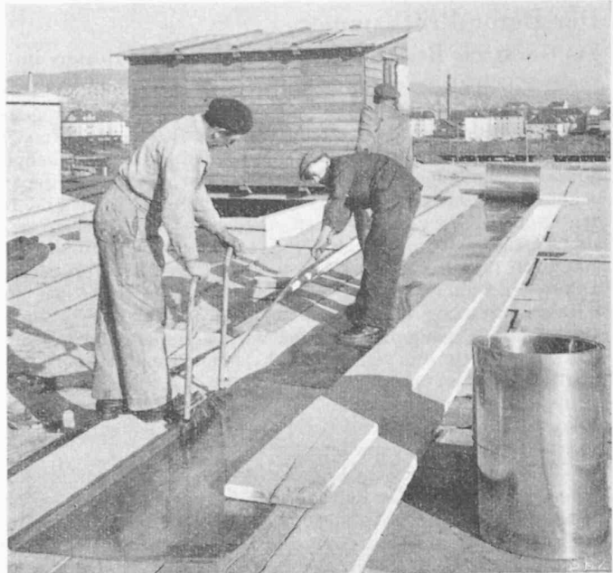
Bild 14. Ziehen des Falzes im Aluman
