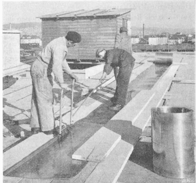
Bild 14. Ziehen des Falzes im Aluman
