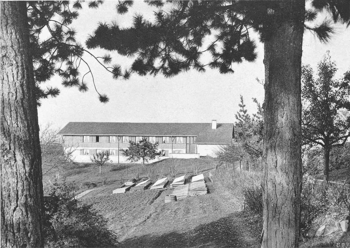
Bild 5. Gesamtansicht aus Osten
