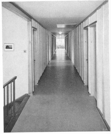
Bild 9. Der obere Korridor mit den beidseitig angeordneten Zimmern. Wände aus verputzten, mit Mineralfarben gestrichenen Perfektaplatten. An der Decke die geschlossene Zugtreppe zum Estrich
