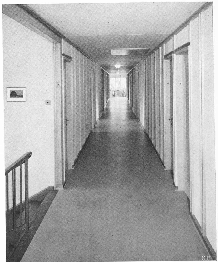
Bild 9. Der obere Korridor mit den beidseitig angeordneten Zimmern. Wände aus verputzten, mit Mineralfarben gestrichenen Perfektplatten. An der Decke die geschlossene Zugtreppe zum Estrich
