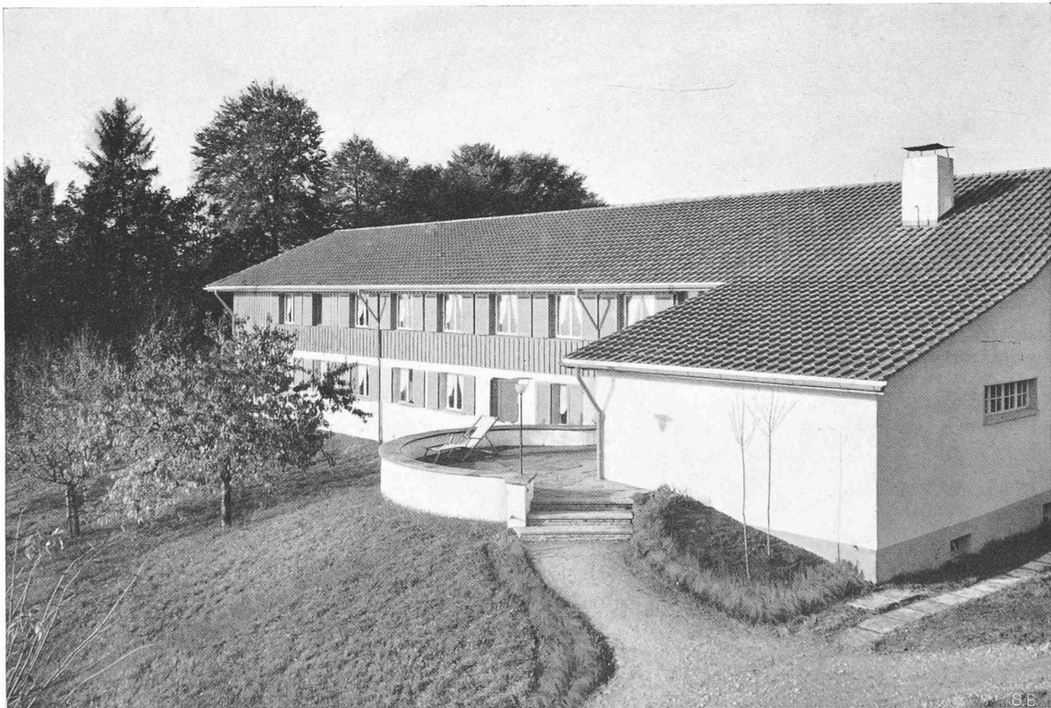
Bild 6. Ansicht mit Sitzplatz und vorgezogenem Aufenthaltsraum Die Nordseite ist bis zum Giebel mit Backsteinmauerwerk ausgeführt
