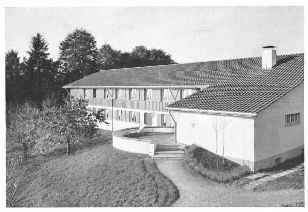
Bild 6. Ansicht mit Sitzplatz und vorgezogenem Aufenthaltsraum Die Nordseite ist bis zum Giebel mit Backsteinmauerwerk ausgeführt
