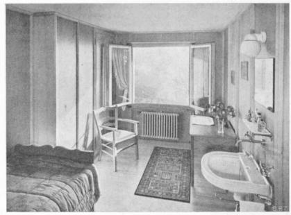
Bild 10. Normales Einerzimmer des Obergeschosses. Naturfarbenes Limbatäfer, mit Leisten zwischen die sichtbare Tragkonstruktion eingesetzt
