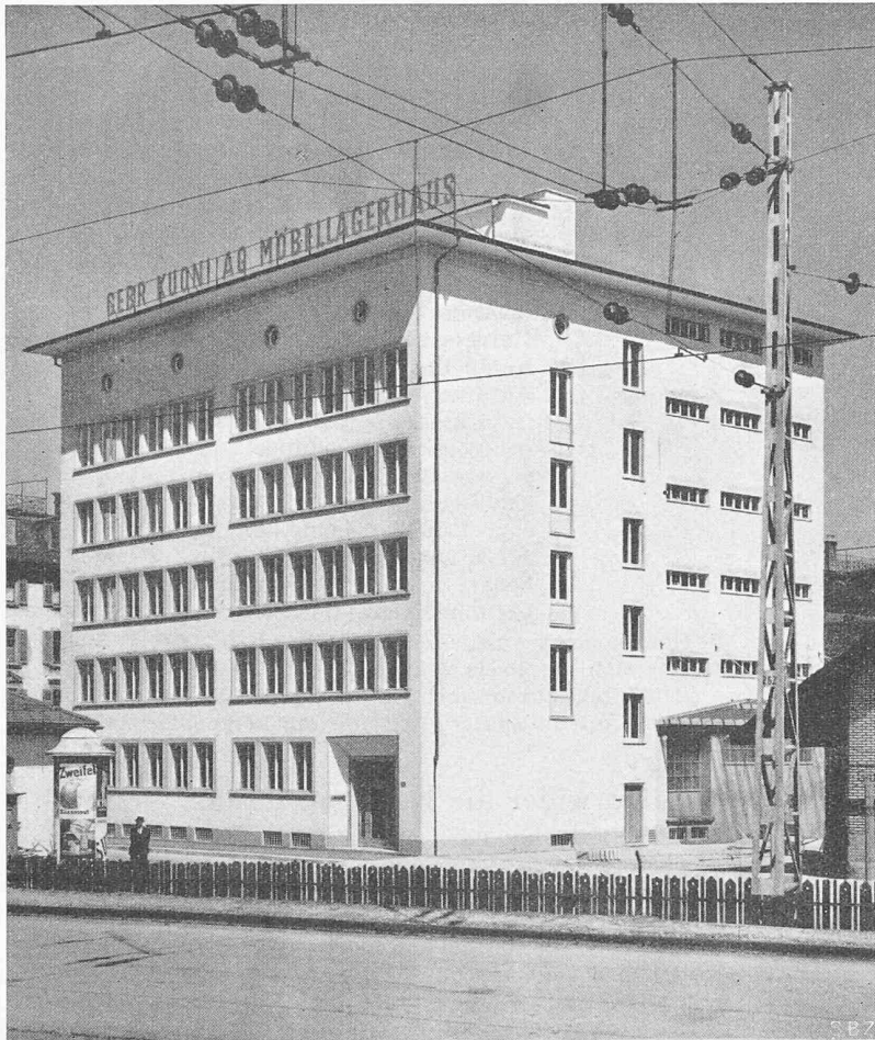
Bild 1. Möbellagerhaus Kuoni, Zürich, Ansicht vom Bahnhof aus
