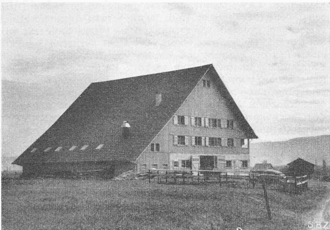
Bild 13. Siedlung Eichhof. Im Prinzip gleicher Typ wie die Siedlung Fischbächli. Wegen der grösseren Betriebsfläche ist die Scheune um ein Binderfeld verlängert und ausserdem ist an Stelle der Remise ein Weidestall für 30 Tiere eingerichtet. Im Bild sind die Oberlichter dieses Stalles sichtbar im Dach, das als Wetterschutz gegen Westen tief heruntergezogen ist. Als Remise wurde zusätzlich ein freistehender Schopf mit Traktoren-Garage erstellt. Der Einbau der Wohnung teilweise über dem Stall ermöglicht die Zusammenfassung des Raumprogrammes in einem klaren, wirkungsvollen Baukörper; gleichzeitig bleibt die ganze Grundfläche zur Ausnützung frei. Der nach Ost-Süd-Ost gerichtete Längsstall und die Südlage der Wohnung sind gut. Die etwas ungünstigere Lage der Küche zum Keller wird mehr als aufgewogen durch die Laube an übersichtsreicher Stelle und den erwünschten direkten Zugang zum Essplatz. Die Aussenwände des Stalles wurden gemauert, der Wohnteil in vertikal verschalter Ständerkonstruktion erstellt.
