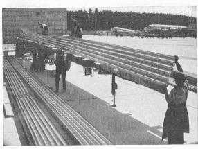
Bild 2. Alumanwellbänder von 24 m Länge für den Hangar I in Kloten
