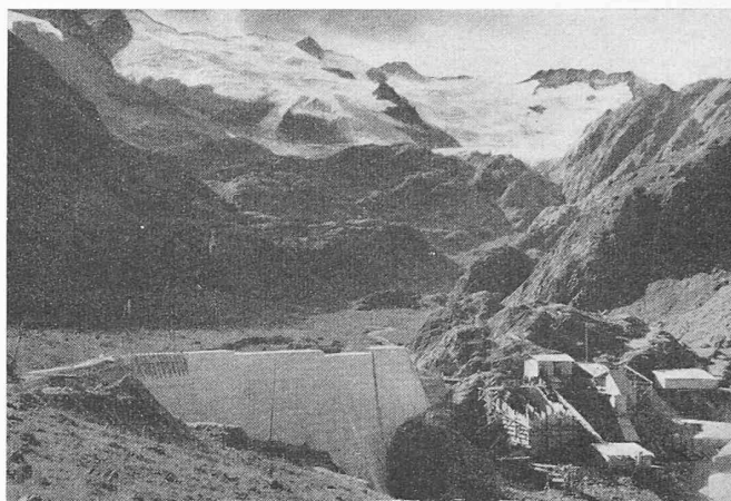
Bild 2. Kraftwerk Handeck II, Staumauer Mattentalp (Urbachtal) aus Fro-Be-Beton
