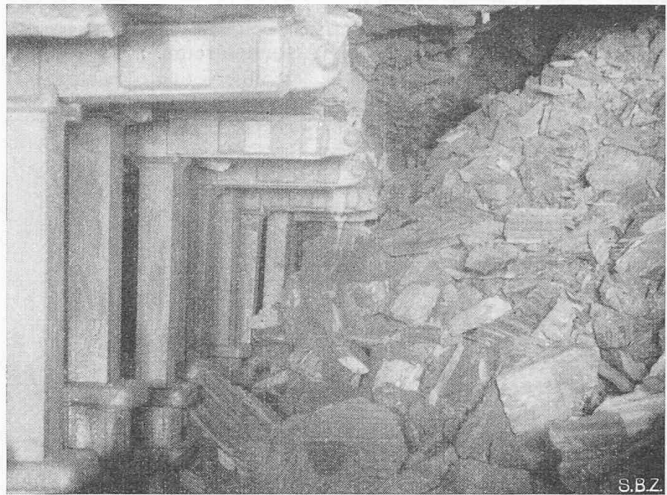
Bild 9. Strebbau (System der Gutehoffnungshütte) und Bruchstoss
