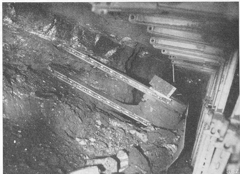
Bild 12. Schrämmaschine mit zwei Schrämarmen (Fabrikat Eickhoff)
