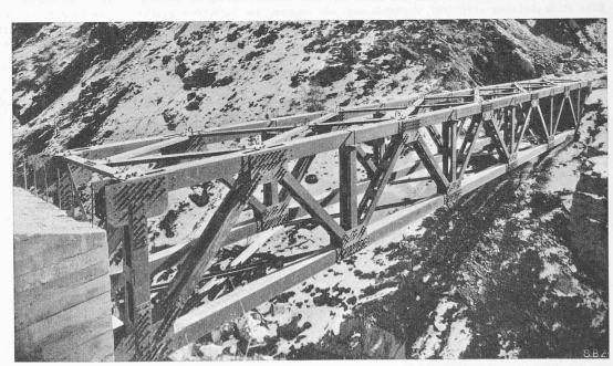
Bild 2. In Südfrankreich montierte Behelfsbrücke System Seibert, Saarbrücken
