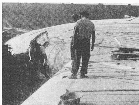
Bild 17. Aufbringen der Kuppelschalung durch natürlich gebogene Schalbretter
