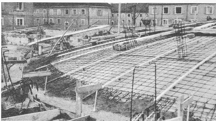
Bild 16. Kuppelarmierung und Anschlusseisen der Pfettenauflager. Beginn des Betonierens in konzentrischen Ringen. An den Galgen sind die schrägen Hängependel der Kuppelauflagerung festgehalten
