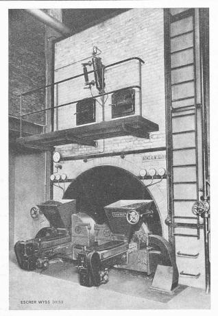
Bild 2. Doppel-Zweiflammrohrkessel von 215 m² Heizfläche, 13 at, mit 2 Doby-Stokern
