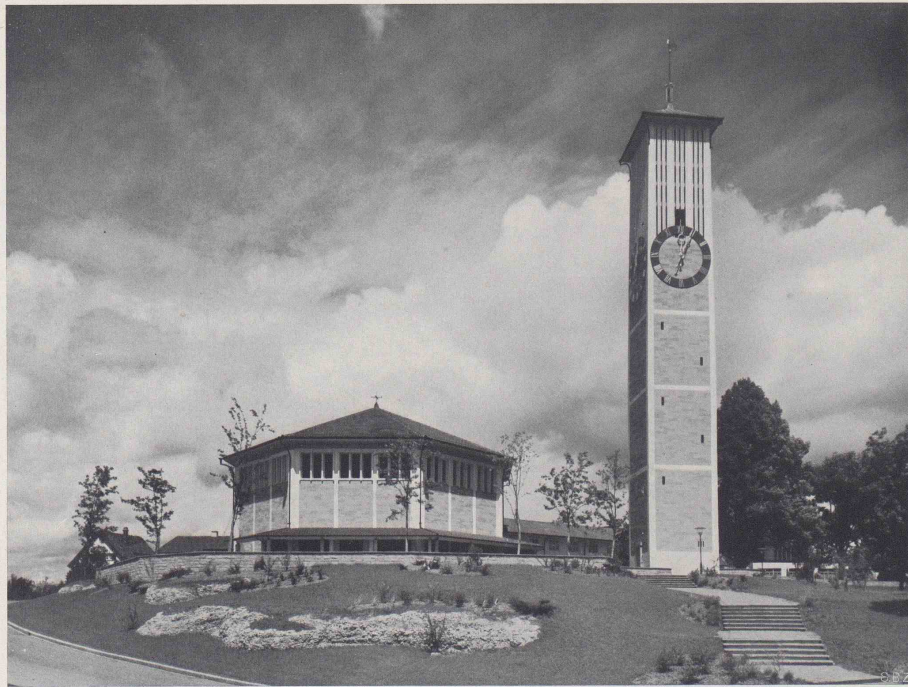
Blick und Zugang von Süden
