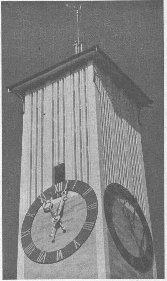
Glockenturm mit armierten Betonlamellen
