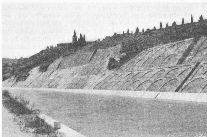
Bild 30. Kraftwerke Medio Adige: Kanalstrecke Ala-Bussolengo mit Hangverbauungen
