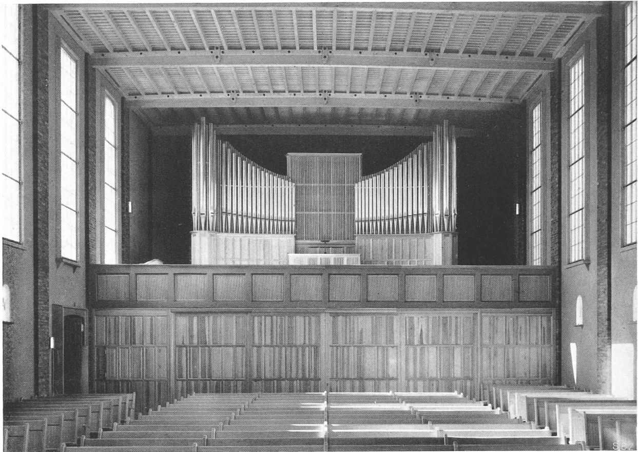
Blick gegen die Empore. Eisenbetonbrüstung mit Akustikfüllungen. Darunter Schiebewand zum Gemeindesaal. Decke ungehobeltes Tannenholz
