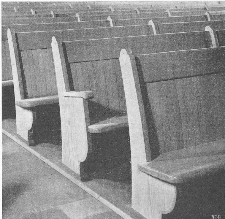
Bild 7. Detail-Ausschnitt Kirchenbänke. Boden Quarzit, eichener Randfries, Douglas-Boden unter den Bänken, diese aus massivem Tannenholz, elektrische Fusschemelheizung
