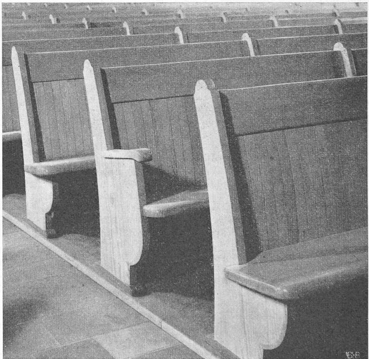
Bild 7. Detail-Ausschnitt Kirchenbänke. Boden Quarzit, eichener Randfries, Douglas-Boden unter den Bänken, diese aus massivem Tannenholz, elektrische Fusschmelheizung
