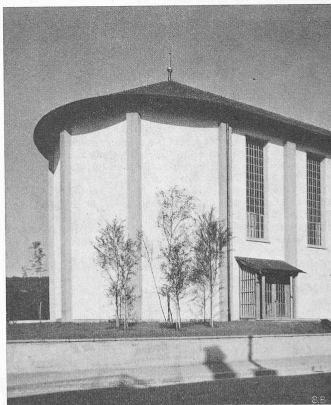
Bild 9. Chorpattie mit kleinem Eingang. Betonpfeiler naturgrau. Backsteinausfachung hell verputzt. Fenster und Eingang Föhrenholz
