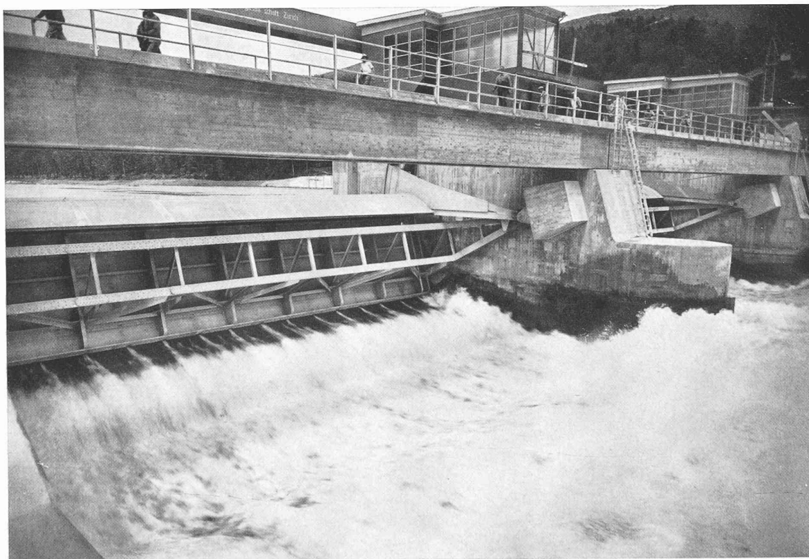
Bild 20. Stauwehr. Sektorhakenschütze der rechten Wehroffnung
