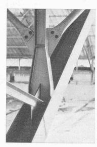
Bild 6. Bogenbinder, Untergurtknotenpunkt mit Kopfstrebenanschluss
