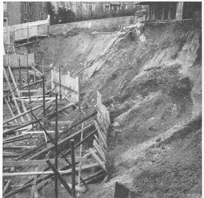
Bild 2. Zustand der Baugrube am 10. Januar 1948
