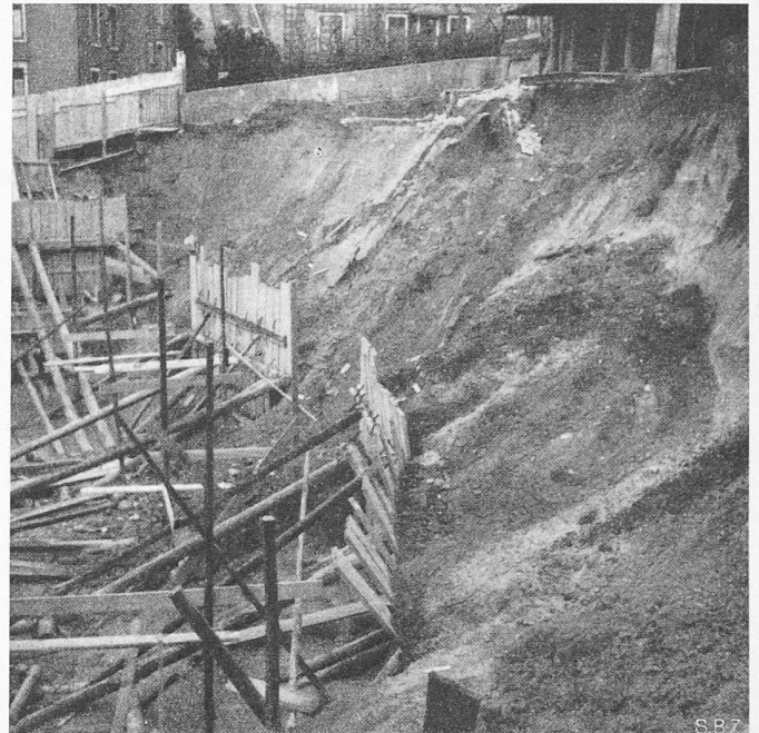
Bild 2. Zustand der Baugrube am 10. Januar 1948
