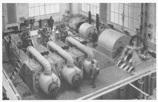
Bild 7. Sulzer-Freikolben-Treibgasanlage von 6000 PS
