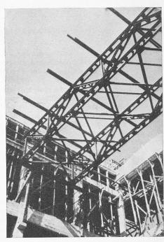
Bild 5. Betonierbrücke in 20 m Höhe
