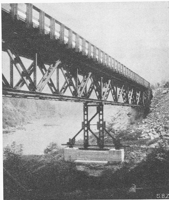
Bild 4. Eingleisige Transportbrücke von 24 + 30 m Stützweite
