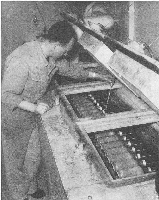
Bild 8. Ansicht des Plasmagefrierapparates mit geöffnetem Deckel
