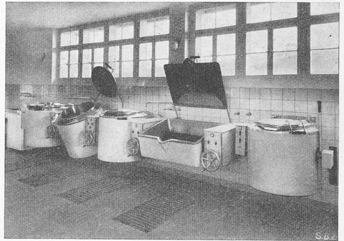
Bild 51. Elektrische Kippkessel-Anlage
