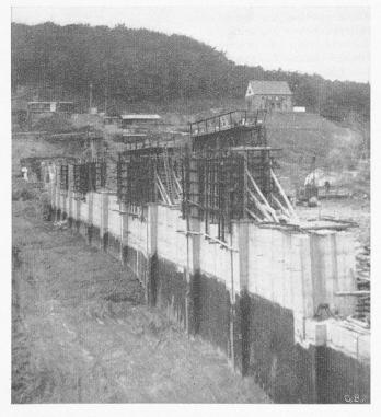
Bild 4. Versetalsperre. Die Wasserseite der Kernmauer mit der eingeschlämmten Lehmdichtung und dem Isolieranstrich
