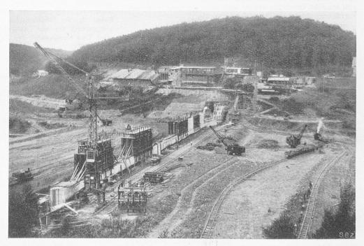
Bild 3. Versetalsperre. Blick von der Luftseite. Im Vordergrund und rechts wird der Stützkörper geschüttet und verdichtet. In der Mitte die Kernmauer im Bau. Darüber im Berghange die Betonfabrik. Links daneben die Sand- und Kiessilos
