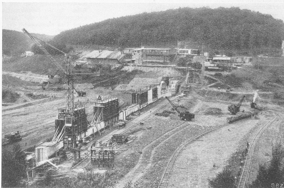
Bild 3. Veresalsperre. Blick von der Luftseite. Im Vordergrund und rechts wird der Stützkörper geschüttet und verdichtet. In der Mitte die Kernmauer im Bau. Darüber im Berghange die Betonfabrik. Links daneben die Sand- und Kiessilos
