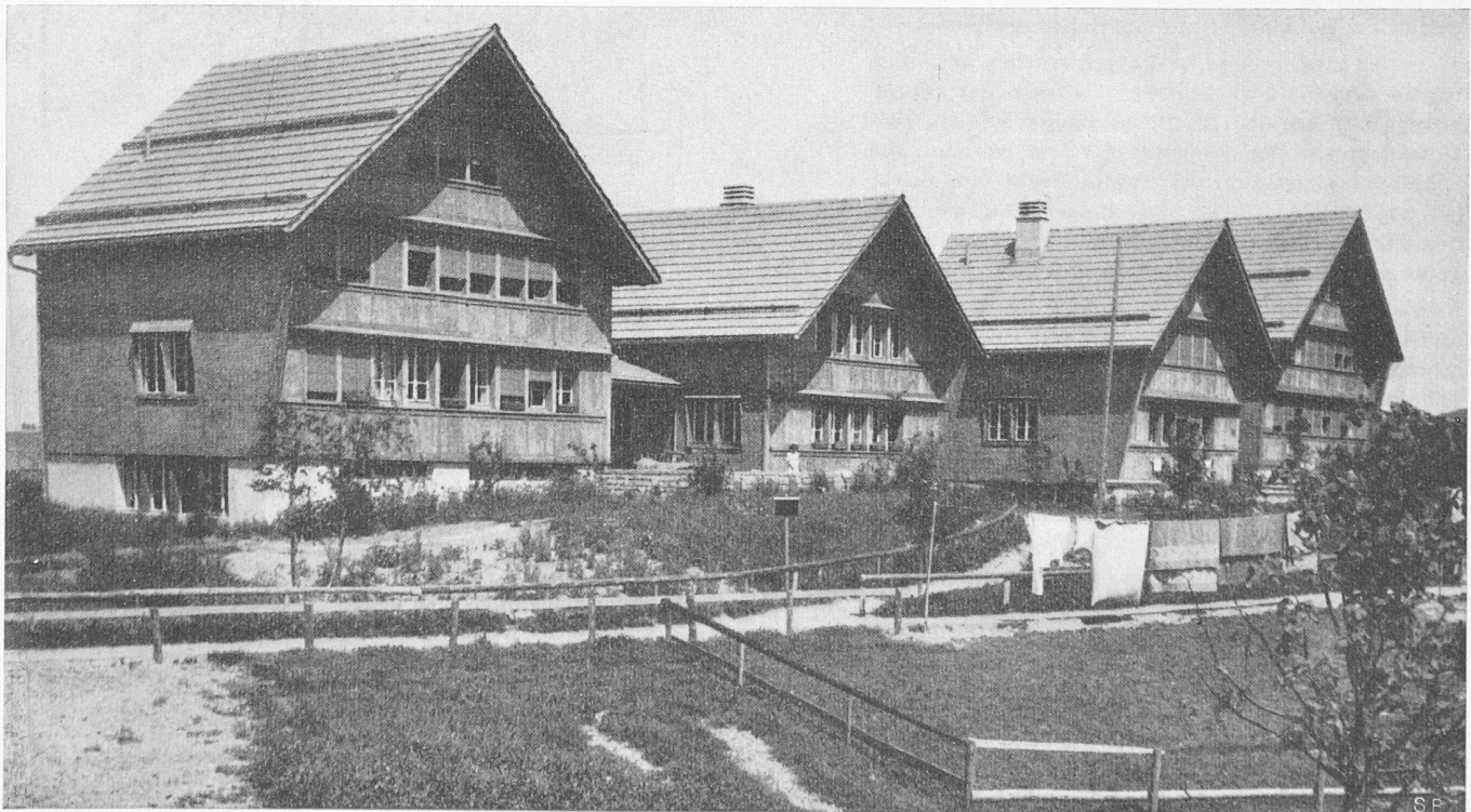
Bild 7. Häuser Nr. 2 und 3, aus Süden, mit traditioneller Holzvertäferung
