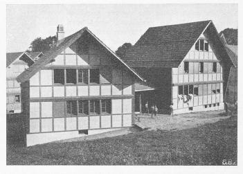
Bild 6. Haus Nr. 5, Vorderfassade mit Eternitverkleidung
