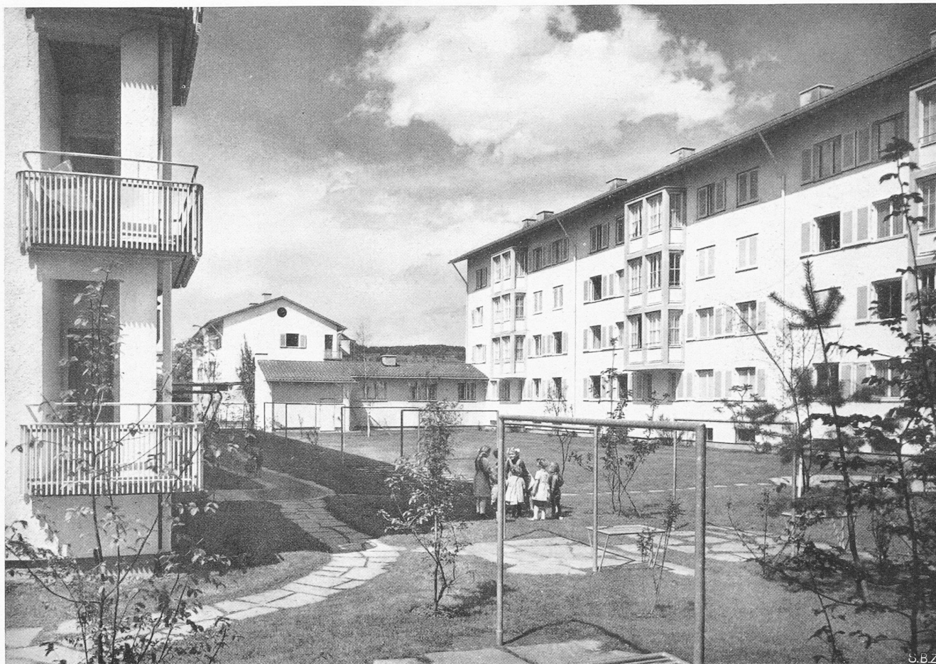
Blöcke mit Dreizimmerwohnungen, angeschlossen je ein Atelier. Blick aus Südwesten
