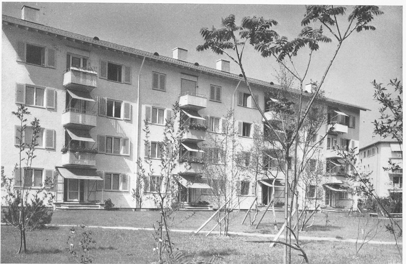
Block mit 16 Vierzimmerwohnungen, aus Südwesten
