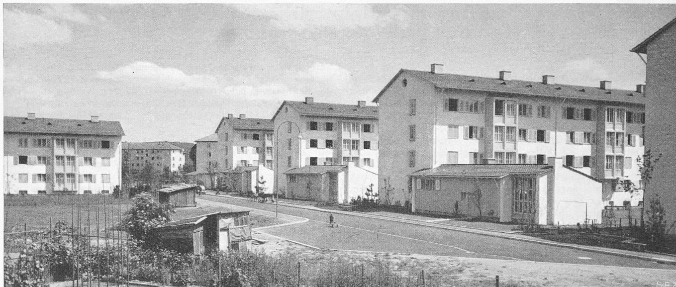
Bild 2. Die Siedlung Heiligfeld I in Zürich 3, aus Nordwesten. Architekten J. SCHÜTZ und A. MURSET, Zürich
